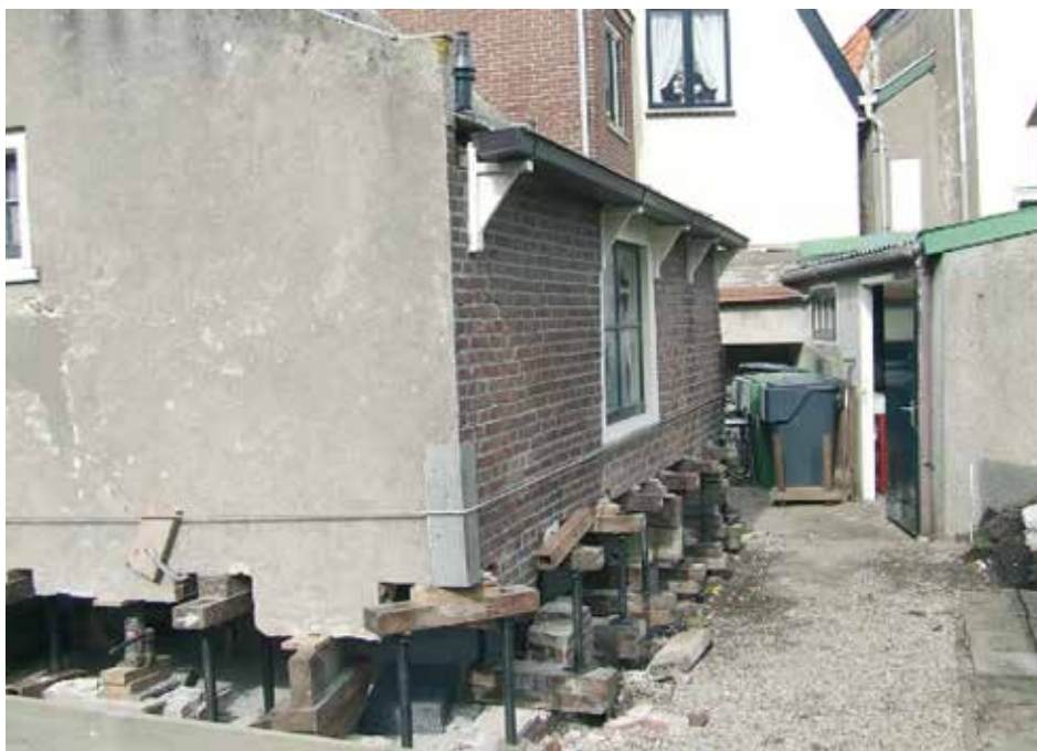
Foto van een huis dat wordt opgevijseld.
