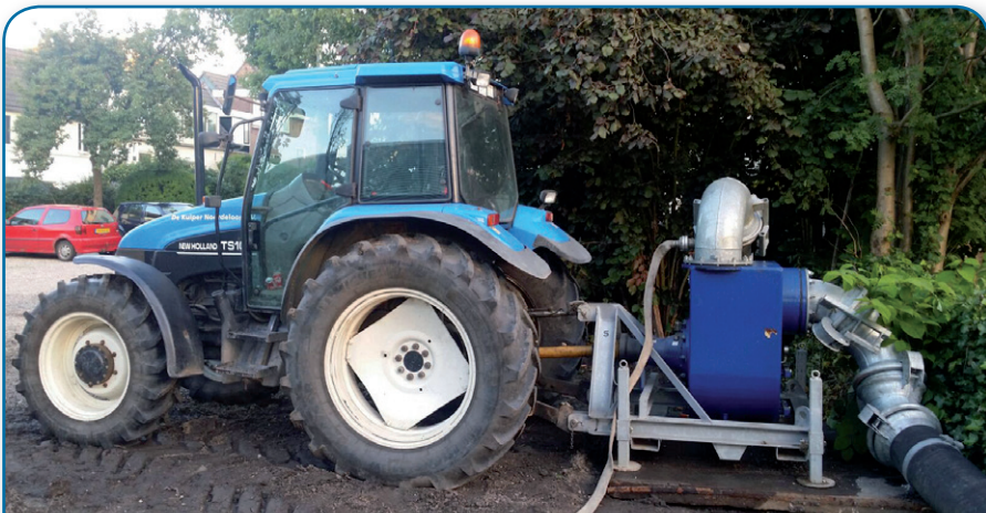
De locatie Merwestreek (Rivierdijk) is een van de vijf plekken in Hardinxveld-Giessendam waar aanvullende bemaling is gerealiseerd.
