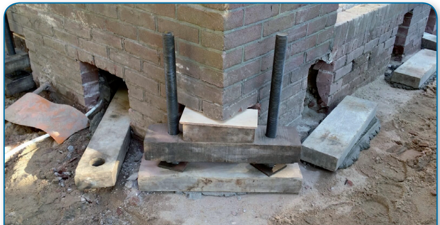
Het opvijzelen van een woning is een duurzame maatregel tegen wateroverlast.
